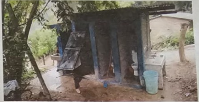
Foto 2: Mejoramiento de servicio sanitario
