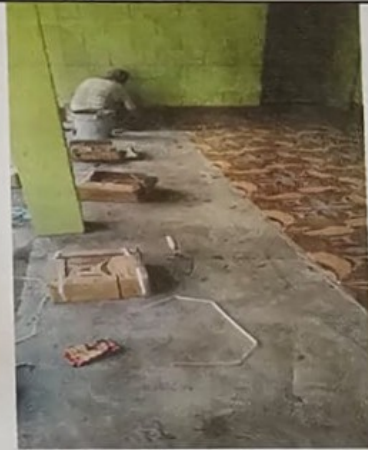
Foto 4: sustitución de piso
